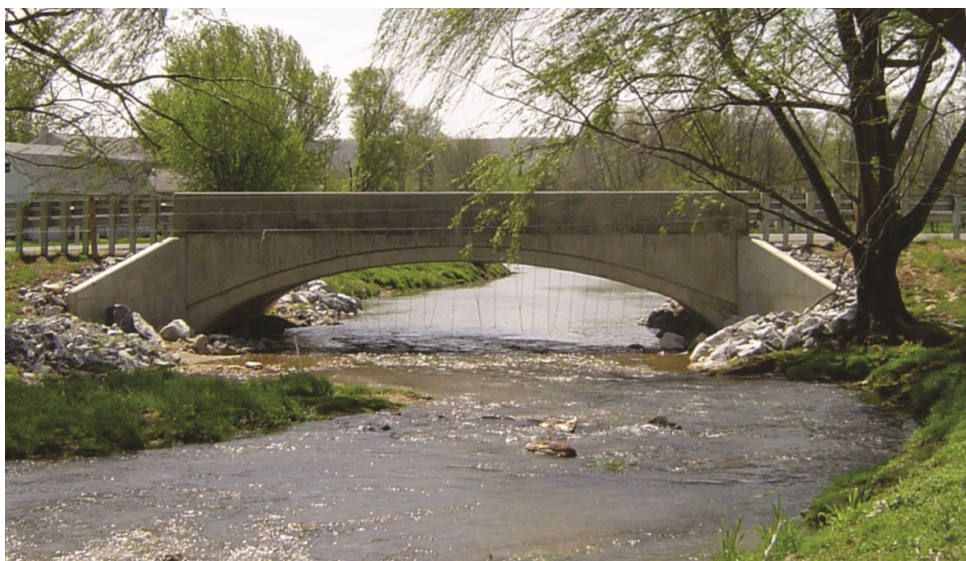
Figure 13 : exemple de pont préfabriqué (source : contech)
