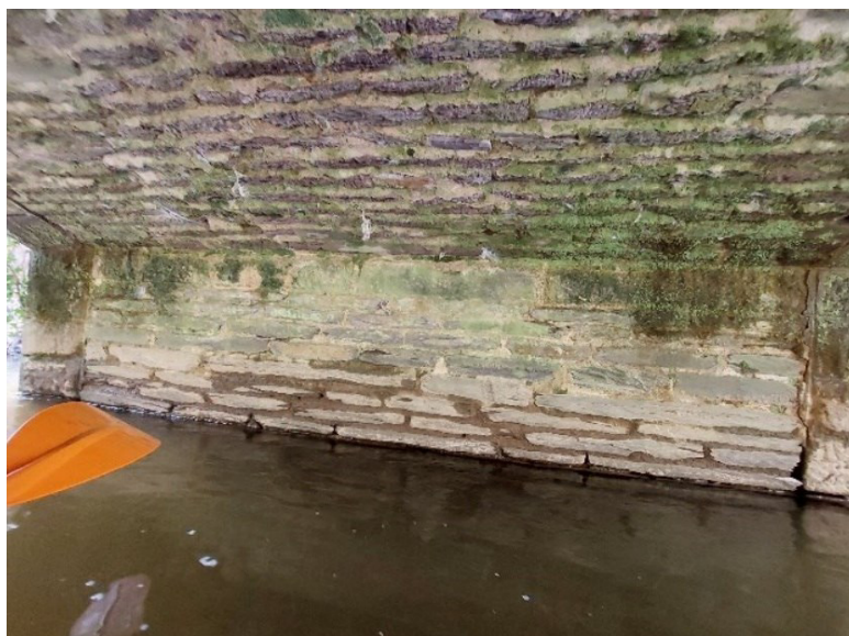
Figure 3 : Photographie de l'intrados de l'ouvrage
