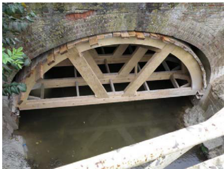
Figure 11 : Cintre en bois pour la démolition du pont de Greycy (source : Setra)
