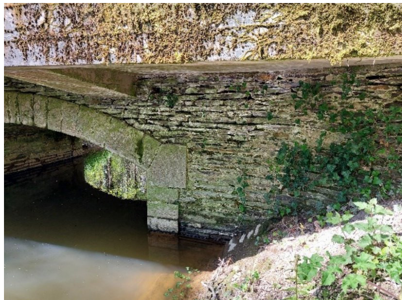
Figure 5 : Photographie du mur en retour côté aval rive gauche
