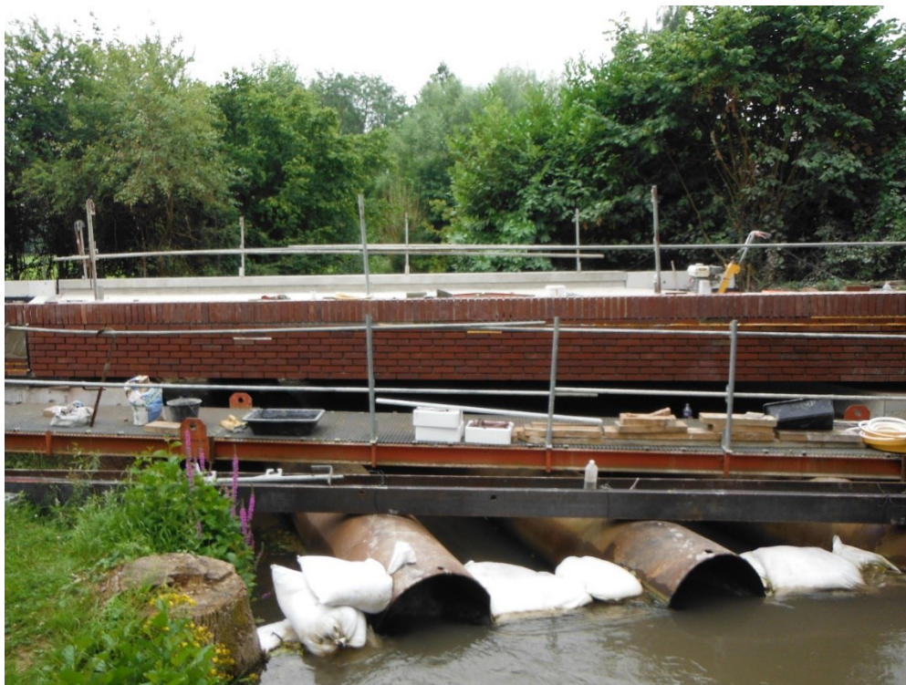
Figure 12 : Système de protection mise en place à Saint-Denis le Thibault
