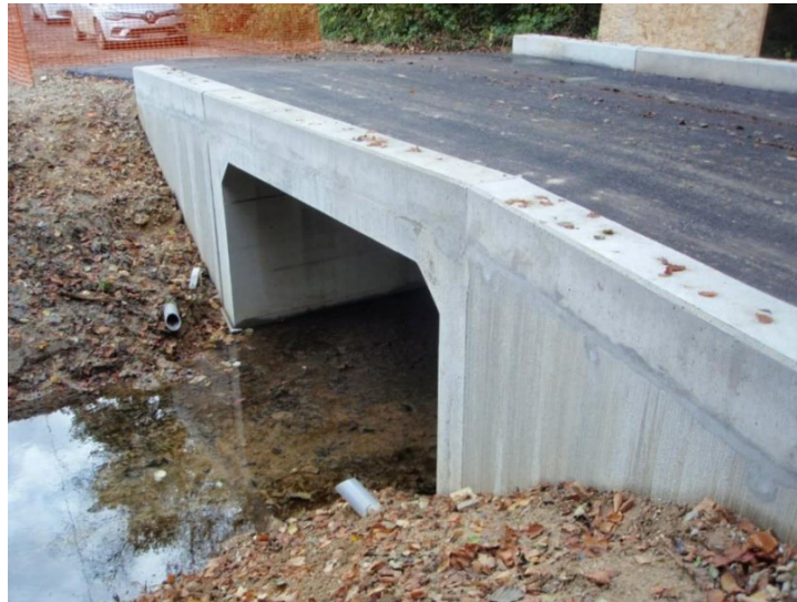
Figure 14 : Photographie de l'ouvrage de Croth, en cours de chantier
