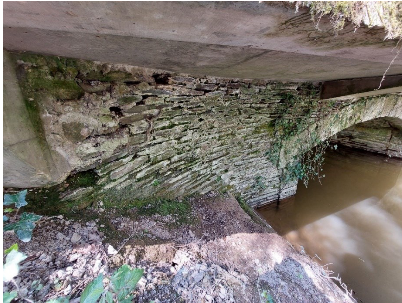
Figure 4 Photographie du mur en retour côté aval rive droite
