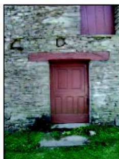
Détails architecturaux. Linteaux en bois peint, murs en pierre, détails de toiture, plaques d'ardoises...
