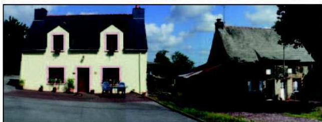
Photos d'habitats du hameau, logis anciens, corps de ferme et pavillon. Photos 1. et 2. Beaux exemples de façades anciennes avec murs en pierre, encadrement de baies et portes en pierre de taille et en plaques de schiste.
