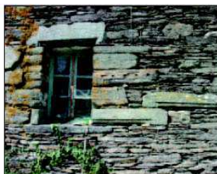
Photos 1. et 2. Détails d'encadrements de petites ouvertures, en plaques de schiste simplement posées ou plus travaillées avec des décors sculptés (ornements, calice). Photos 3. 4. 5. Exemples de composition de façades. Alignement de baies.
