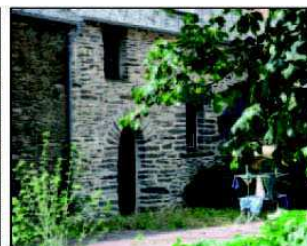
Photos 1. et 2. Détails d'encadrements de petites ouvertures, en plaques de schiste simplement posées ou plus travaillées avec des décors sculptés (ornements, calice). Photos 3. 4. 5. Exemples de composition de façades. Alignement de baies.
