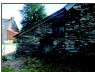
Photos d'habitats du hameau, logis anciens, corps de ferme et pavillon. Photos 1. et 2. Beaux exemples de façades anciennes avec murs en pierre, encadrement de baies et portes en pierre de taille et en plaques de schiste.
