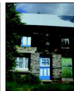
Détails architecturaux. Linteaux en bois peint, murs en pierre, détails de toiture, plaques d'ardoises...
