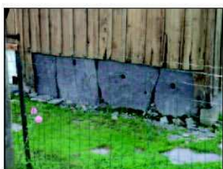
Photos d'habitats du hameau, logis anciens, corps de ferme et pavillon. Photos 1. et 2. Beaux exemples de façades anciennes avec murs en pierre, encadrement de baies et portes en pierre de taille et en plaques de schiste.
