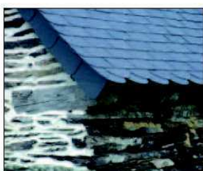
Photos d'habitats du hameau, logis anciens, corps de ferme et pavillon. Photos 1. et 2. Beaux exemples de façades anciennes avec murs en pierre, encadrement de baies et portes en pierre de taille et en plaques de schiste.
