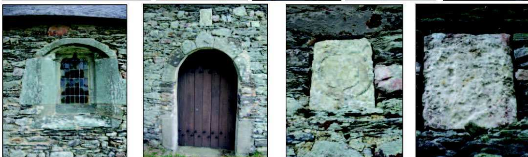
Détails architecturaux. Photos 1. à 5. Vues de l'intérieur: charpente conservée et restaurée, lambris non d'origine récemment posé. Vues sur les croix et statues (mobilier religieux répertorié).
