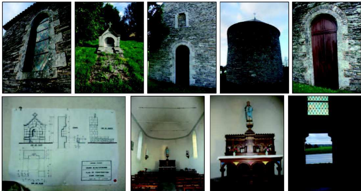
Détails architecturaux. Photos 1. à 5. Vues extérieures. Détails de baies, petit oratoire sur l'arrière, pignon principal et pignon arrondi, encadrement des portes et baies en pierre de taille et renfort en plaques de schiste.
