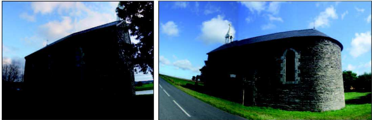
Inscription de la Chapelle dans le site. Deux vues générales, dont une montre la proximité de la route.
